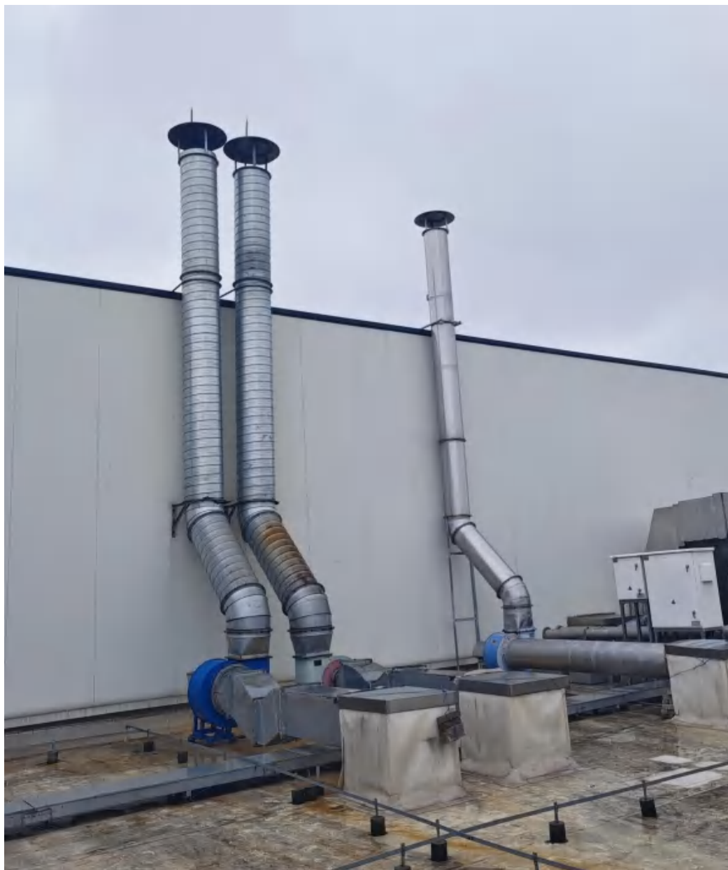
图 4-2 废气排气筒
